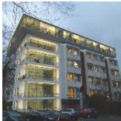
Klinikverbund St. Antonius und St. Josef Petrus-Krankenhaus Wuppertal Aufstockung der Station 4c zur Wahlleistungsstation
