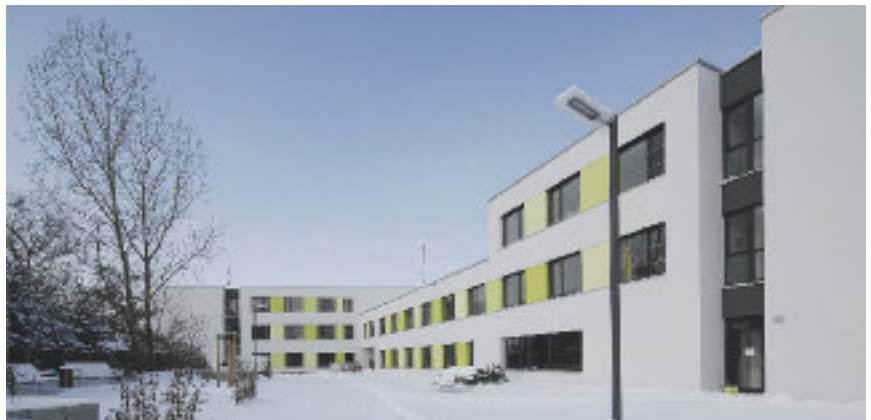
Rehabilitationsklinik mit Facharztzentrum Großenhain Fassade Neubau
